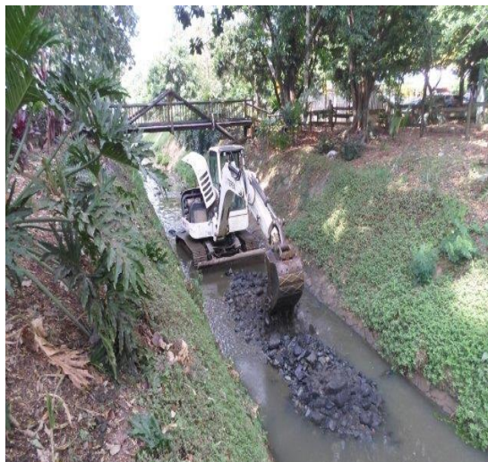
Quebrada La Presidenta- Sector Patio Bonito (Remoción Sedimentos)
